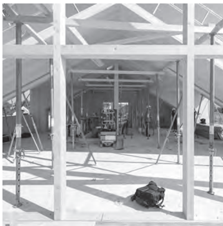
Im dreigeschossigen Gebäude werden insgesamt 230m 3 pures Holz verbaut.
