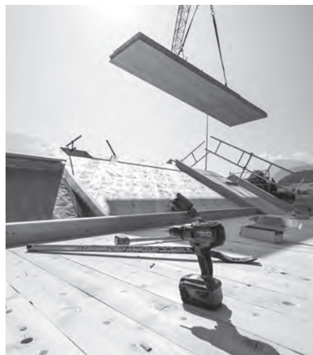
Die einzelnen Vollholzelemente wiegen bis zu zwei Tonnen.
